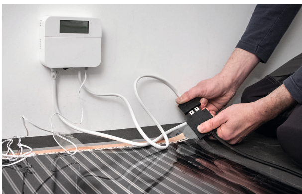
4 Sätt upp kontrollen och koppla den till värmefolien
